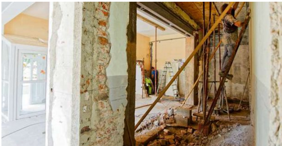
Eine geplante Sanierung kann eine Kündigung rechtfertigen. Bild zVG
