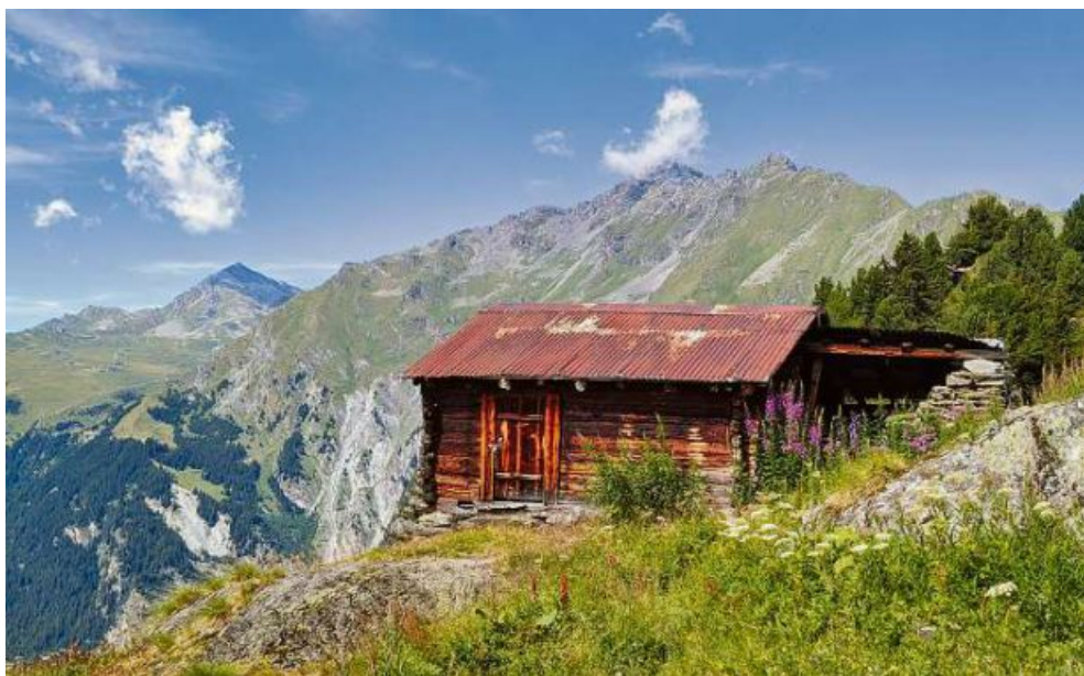
Bauten ausserhalb der Bauzonen profitieren bald von neuen gesetzlichen Grundlagen des Bundes. Bild zVg
